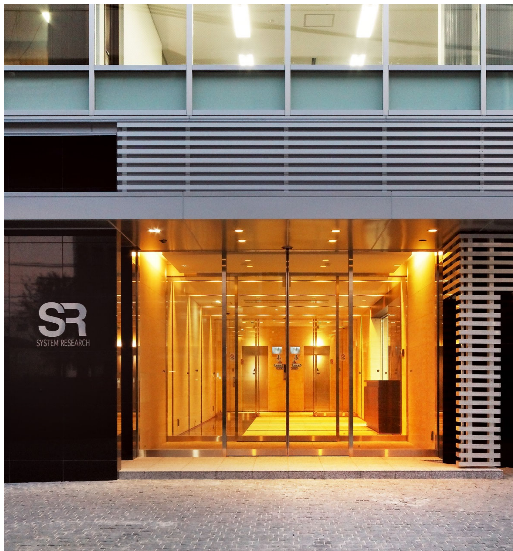
本社ビル・正面から(中村区岩塚本通)
